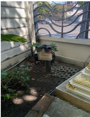
ภาพที่ 2-16 ติดตั้งหัวรับน้ำดับเพลิงภายนอกอาคาร
