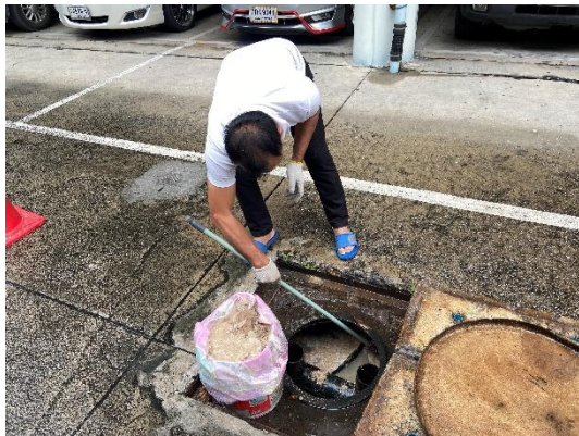
ภาพที่ 2-4 ตักกากตะกอนออกจากถังตะกอนเป็นประจำทุกสัปดาห์
